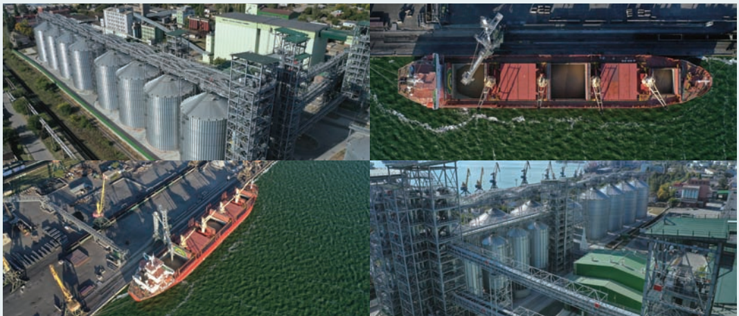
그림 3 포스코인터내셔널 곡물수출터미널 및 선석 전경
