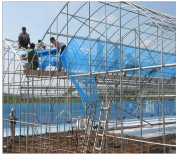
양묘장 비닐온실 건축공사 장면 (평양 순안양묘장)
